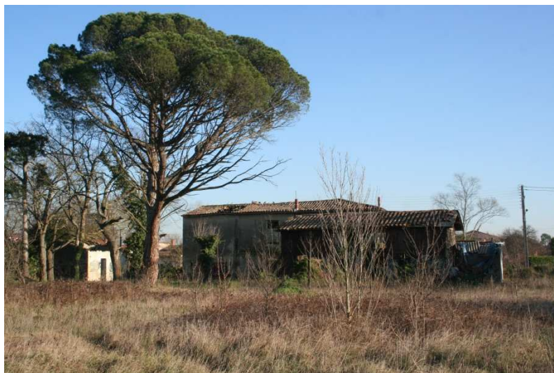
8. Ferme en ruine abritant la colonie de Pipistrelle de Kuhl – 10/01/2012 – photo ADRET
